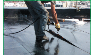
3. Soudage des joints de recouvrement de la première couche d'étanchéité.
