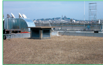
5. Pose de la protection lourde
