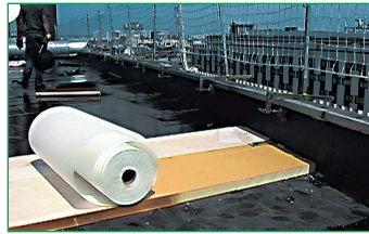
2. Pose de la 1 ère couche d'étanchéité sur écran VV 100 si nécessaire
