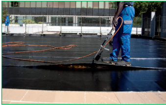
4. Pose et soudage de la 2 ème couche d'étanchéité
