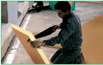
1. Découpe et pose de l'isolant en quinconce. En 2 lits, pose des lits à joints décalés.
