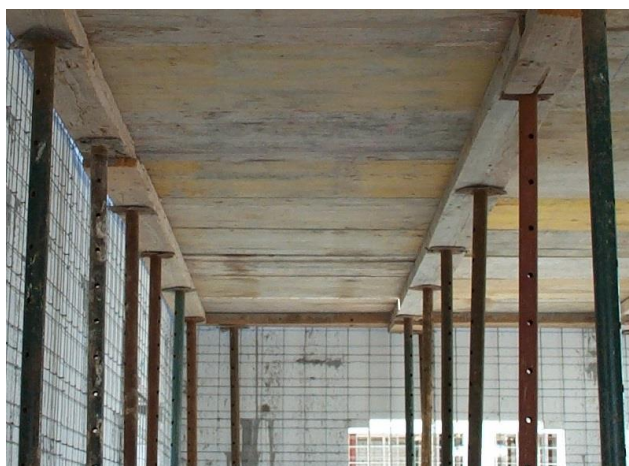
Figure 30 Etais de dalle supportant poutres et planches de coffrage
