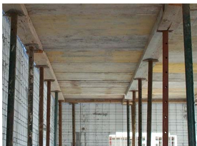
Figure 28 Etais de dalle supportant poutres et planches de coffrage
